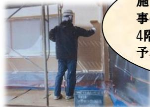
施設保全計画の外壁塗装工事のうち、特に亀裂が見られた4階外壁を平成26年度補正予算で改修しました
